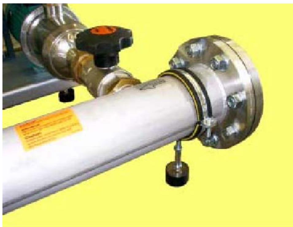
Рис. 8. Закрепление коллектора при помощи опоры с амортизатором
